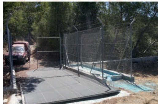
Foto 6. Pediluvio y fosa de hormigón provista de una cubierta abatible
